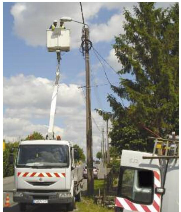
*Remplacement d'une lampe au mercure par une lampe au sodium*
