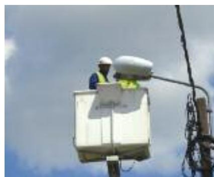
*Remplacement d'une lampe au mercure par une lampe au sodium*
